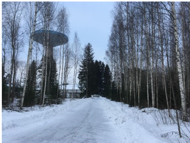
Vesitorni ja voimassa olevan asemakaavan tontille 4 johtava Katilantie kaava-alueen keskiosassa.
