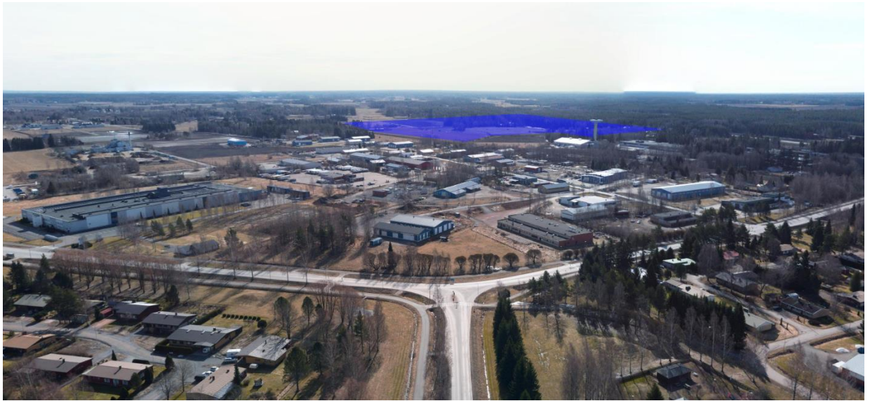
Peipohjan Järiläntien ja Satakunnantien liittymästä Suokkaan yritysalueen yli kohti Peipohjan vesitornia ja kaavahankealuetta. Vasemmalla Sinituotteen 14 000 m 2 tehdasrakennus.
