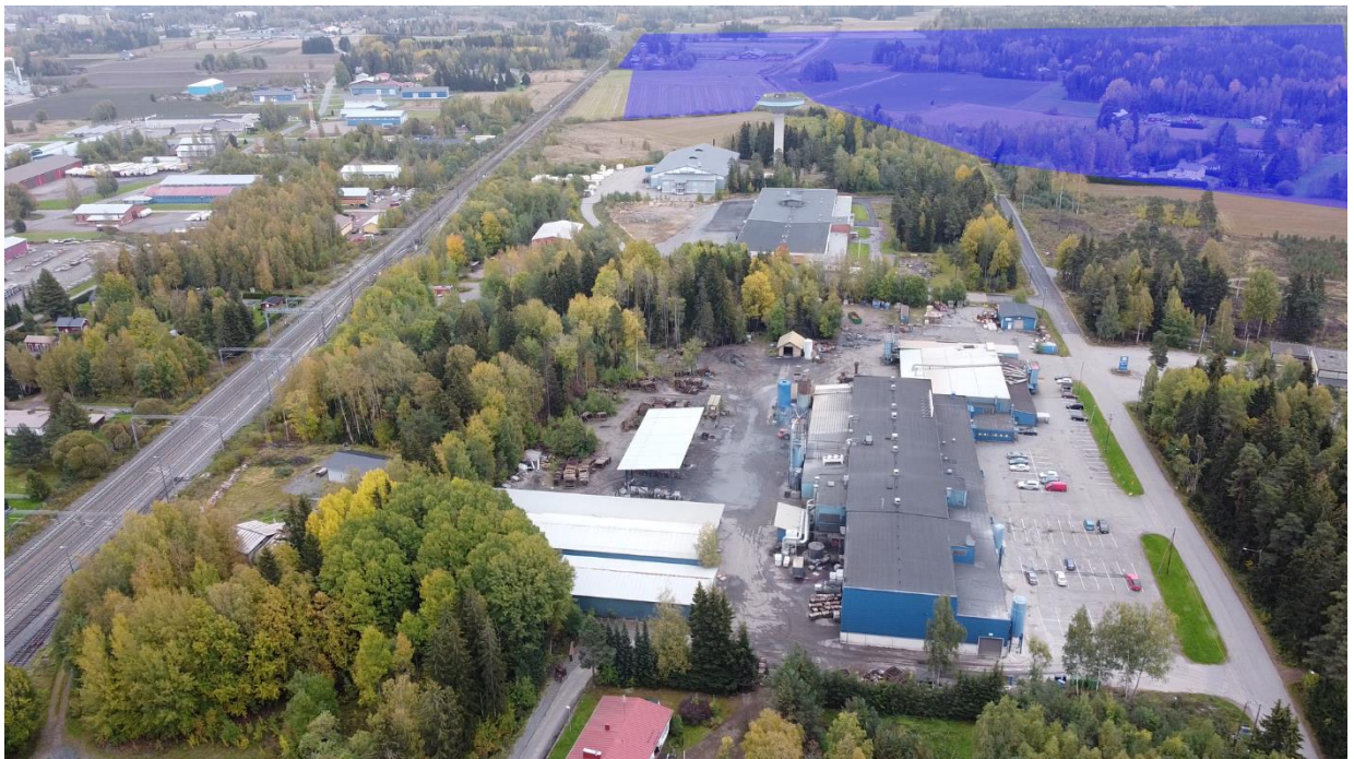
Satakunnantieltä ratapihan ja Teollisuustien välistä kohti Peipohjan vesitornia ja kaavahankealuetta. Etualalla Peironin 6000 m 2 valimohalli, Vesitornin juurella Kokemäen Bulgan 6000 m 2 teollisuushalli ja vasemmalla puolella FinnEPS:in 3500 m 2 halli.
