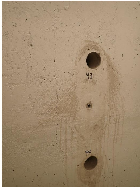
Kuva 15. Laajennusosan maanvastaisessa seinässä ei havaittu isoja halkeamia. Seinien betoneista otettiin poralieriönäytteitä betonitutkimuksia varten.
