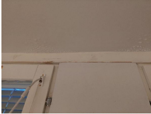
Kuvat 49a ja b. Rakenneliittymissä todettiin monin paikoin kosteuden tiivistymistä.
