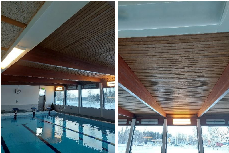
Kuva 71. Allasosaston katto on paneloitu.
