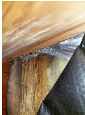
Kuvat 50a...c. Rakenneliittymissä havaittiin kosteuden aiheuttamia jälkiä sekä pintarakenteissa että runkorakenteiden (puurunko/apukarmit) sisäpinnoilla.
