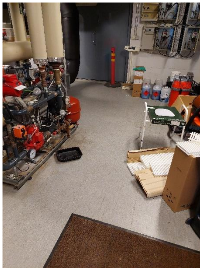
Kuva 31. Yleiskuva IV-konehuoneen muovimattopäällysteestä.
