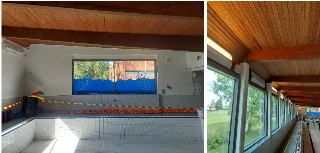
Kuva 45a ja b. Ulkoseinät ovat pääosin tiili-villa-tiilirakenteisia. Ikkunoiden yläpuolella ulkoseinät ovat puurakenteisia ja sisäverhouksena on puupaneeli- tai kuitusementtilevy.
