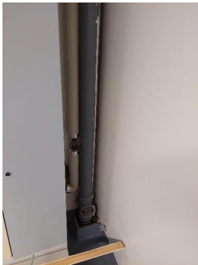
Kuvat 23a ja b. Viemäreiden tuuletusputkien läpivientejä tarkasteltiin pistokoeluonteisesti. Läpivienneissä ei todettu aistinvaraisesti tai merkkisavulla ilmatiiveyspuutteita ja alapohjarakenne on valettu kiinni tuuletusputkeen.
