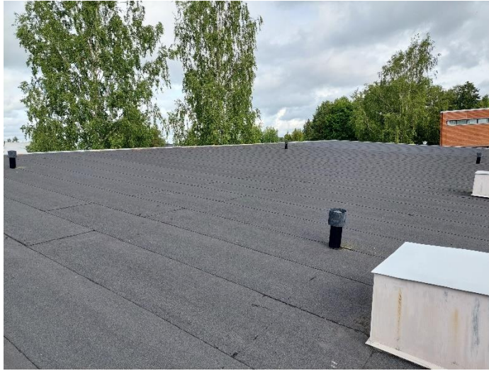
Kuva 55. Yleiskuva vesikatoilta. Vesikattomuoto on pulpettikatto ja vedeneristeenä on bitumikermi. Yläpohjarakenne tuulettuu räystääiltä ja alipainetuulettimien avulla.
