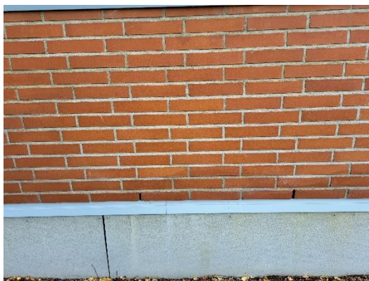
Kuva 38a...c. Betonirakenteiset sokkelit on länsiseinustalla ja osittain eteläseinustalla verhoiltu kuitusementtilevyillä (kuvat a ja b). Tiilimuurauksen alaosa on tuuletusraot joka kolmannessa pystysaumassa (kuva c).
