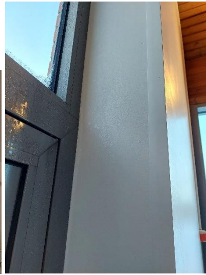
Kuvat 49a ja b. Rakenneliittymissä todettiin monin paikoin kosteuden tiivistymistä.
