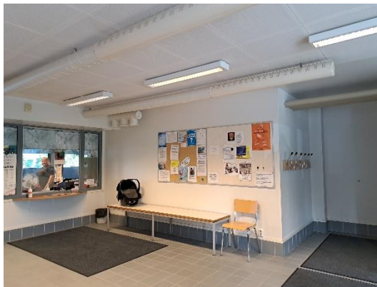
Kuvat 69 a...c. Pesutilojen katot on paneloitu (kuva a). Pukuhuoneissa ja aulassa on kiinteä kipsilevyalakatto (kuvat b ja c).
