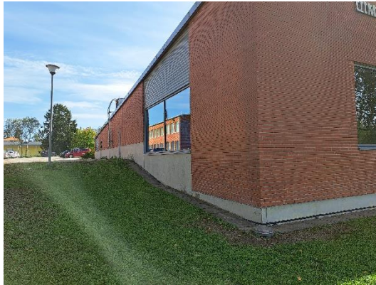
Kuvat 37a ja b. Julkisivut ovat pääosin tiiliverhoituja. Ikkunoiden yläpuolella on pääosin profilipeltiverhoitus. Allasosaston MEK-ikkunoissa ei todettu merkittäviä puutteita.
