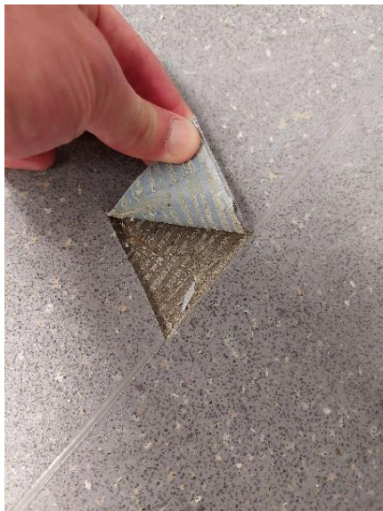
Kuva 26. Yleiskuva viiltomittauksesta, jossa ei havaittu viitteitä kiinnitysliiman vaurioitumisesta.
