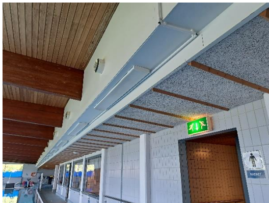
Kuva 70. Allasosaston käytävällä alakatto on pääosin sementtilastulevyä.
