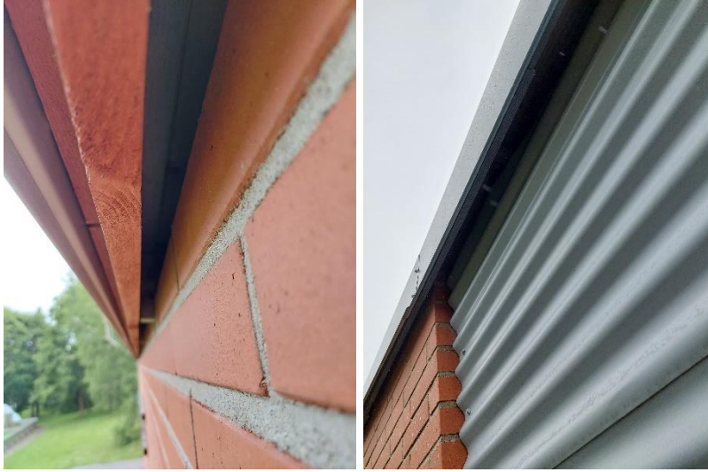
Kuva 63. Julkisivujen ja räystään liittymissä ei ole myrskypeltiä eikä liittymä ole vesitiivis, jolloin esim. tuiskulumi voi kulkeutua ulkoseinärakenteen tai yläpohjan eristetilaan.
