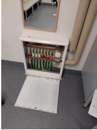
Kuvat 22a ja b. Lattialämmityksen jakotukien kohdalla havaittiin paikoin epätiivitä läpivientejä/rakenneliittymiä. Jakotukien kohdalla ei ole vedeneristystä.
