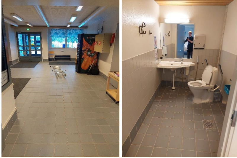
Kuvat 16a ja b. Yleiskuvat aulasta ja aulan yhteydessä olevasta inva WC-tilasta. Tiloissa on lattiapäällysteenä keraaminen laatta ylösnostolla.
