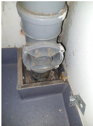
Kuvat 23a ja b. Viemäreiden tuuletusputkien läpivientejä tarkasteltiin pistokoeluonteisesti. Läpivienneissä ei todettu aistinvaraisesti tai merkkisavulla ilmatiiveyspuutteita ja alapohjarakenne on valettu kiinni tuuletusputkeen.
