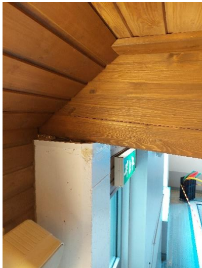
Kuvat 78a...d. Yläpohjan kantavat rakenteet ovat liimapuupalkkeja, joissa todettiin paikoin vaakasuuntaisia halkeamia.
