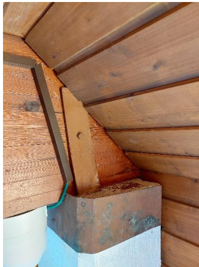
Kuvat 78a...d. Yläpohjan kantavat rakenteet ovat liimapuupalkkeja, joissa todettiin paikoin vaakasuuntaisia halkeamia.
