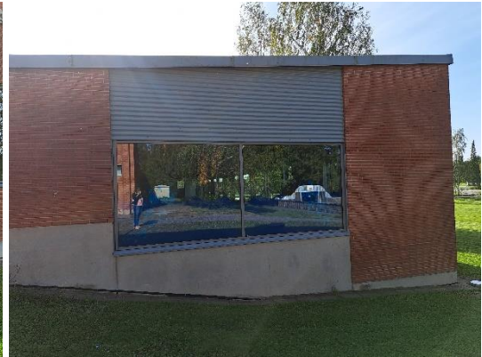
Kuvat 37a ja b. Julkisivut ovat pääosin tiiliverhoituja. Ikkunoiden yläpuolella on pääosin profilipeltiverhoitus. Allasosaston MEK-ikkunoissa ei todettu merkittäviä puutteita.
