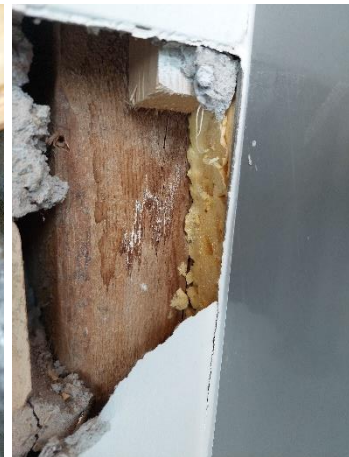
Kuvat 50a...c. Rakenneliittymissä havaittiin kosteuden aiheuttamia jälkiä sekä pintarakenteissa että runkorakenteiden (puurunko/apukarmit) sisäpinnoilla.
