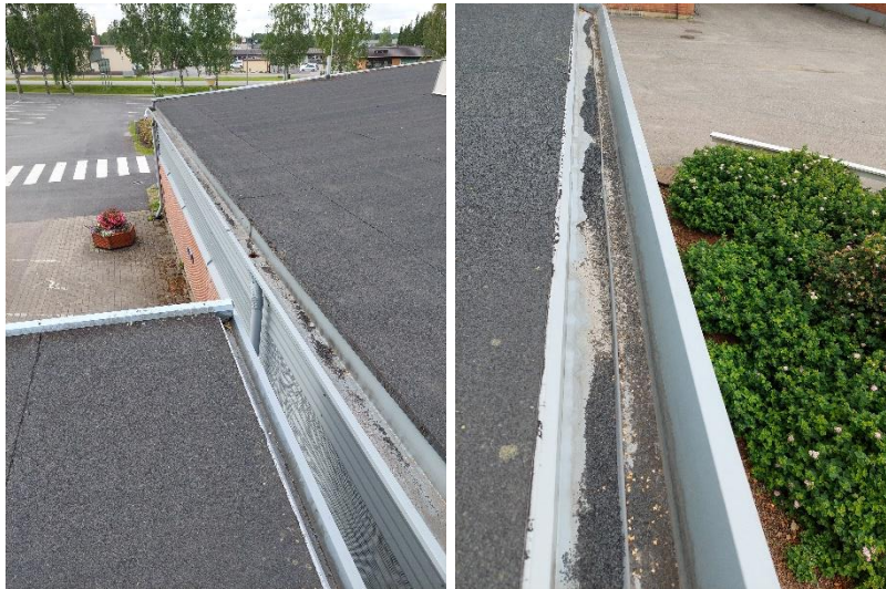
Kuva 58a ja b. Vesikaton vedenpoisto on järjestetty ulkopuolisella vedenpoistojärjestelmällä, jossa ei havaittu merkittäviä puutteita. Räystäskouruissa on paikoin sulanapitokaapelit (ei kaikkialla).
