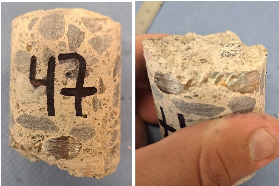
Kuvat 89 a ja b. Näyte N47 tasausaltaan ulkopinnasta. Näytteessä raudoite sijaitsee noin 50 mm:n syvyydellä rakenteen ulkopinnasta, murtopinnalla. Näytteiden betonissa tai betonin raudoitteessa ei havaittu silmämääräisesti viitteitä vaurioitumisesta.
