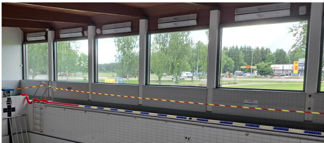
Kuva 60. Yleiskuva allashuoneen ulkoseinälinjalla olevista pilareista. Tutkitut pilarit sijaitsevat allashuoneen ulko- ja väliseinälinjoilla ja kannattelevat vesikaton liimapuupalkkeja.
