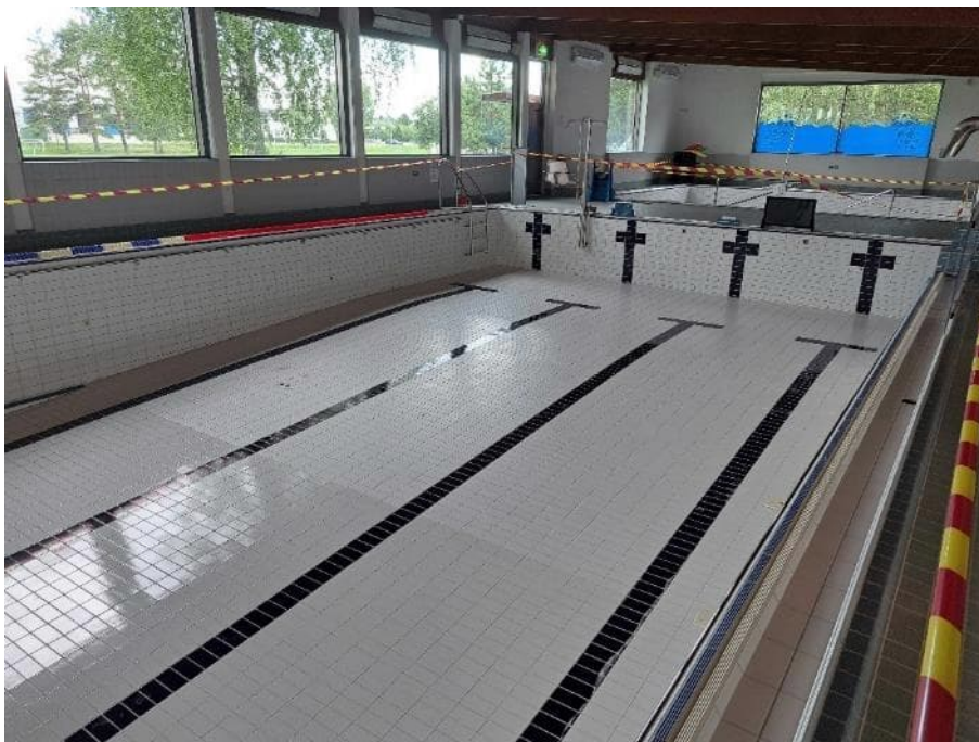
Kuva 3. Yleiskuva 25 metrin uima-altaasta, altaan matala pää. Altaan pohjan laatoituksessa on havaittavissa lasitetun ja karhennetun laatoituksen rajapinta.
