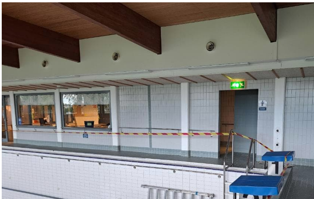
Kuva 61. Yleiskuva allashuoneen ulkoseinälinjalla olevista pilareista. Tutkitut pilarit sijaitsevat allashuoneen ulko- ja väliseinälinjoilla ja kannattelevat vesikaton liimapuupalkkeja.
