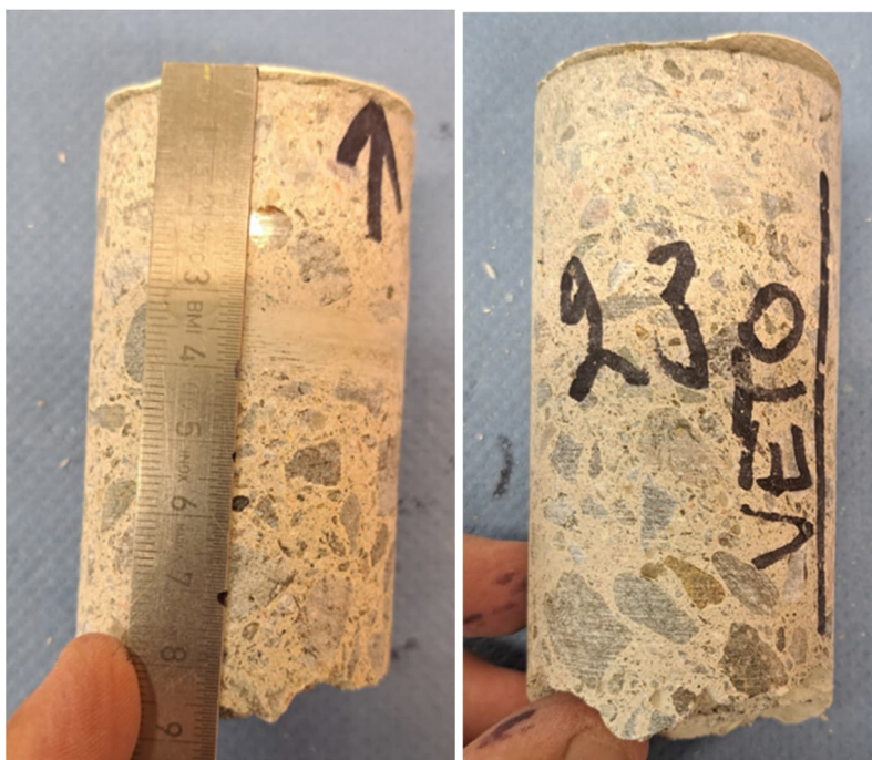
Kuvat 72 a - b. Näytteet N22-N23 allashuoneen pilareista. Näytteessä N22 raudote sijaitsee noin 18 mm:n syvyydellä rakenteen ulkopinnasta. Näytteiden betonissa tai betonin raudoitteessa ei havaittu silmämääräisesti viitteitä vaurioitumisesta.
