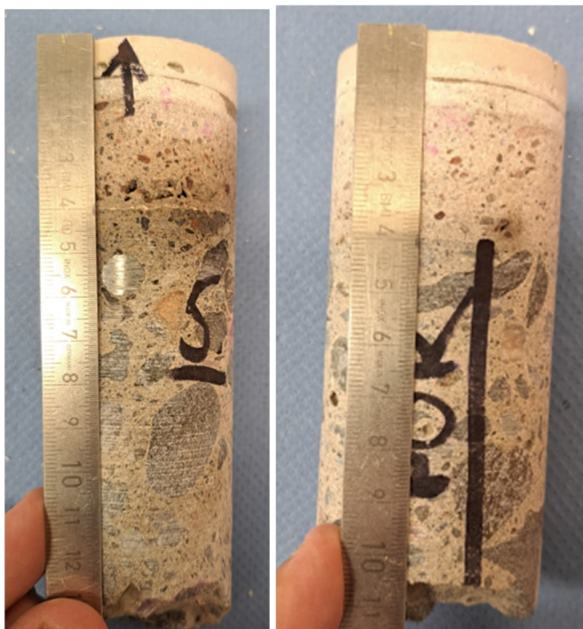
Kuvat 31 a ja b. Näytteet N5 ja N6 altaan seinästä. Näytteiden yläpinnassa on pintarakenteet, joiden alla on n. 25 mm:n tasoitekerros. Näytteen N6 laatan ja kiinnityslaastin tartunnassa on laastikamman urat näkyvissä. Näytteessä N5 raudoite on noin 55 mm:n syvyydellä rakenteen ulkopinnasta. Raudoitteet ovat silmämääräisesti arvioituna hyväkuntoisia.
