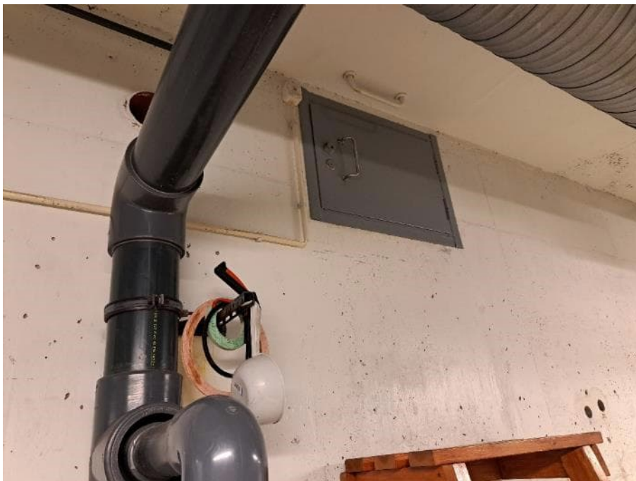
Kuva 81. Ison tasausaltan seinämä ja kulkuluukku tasausaltaaseen.
