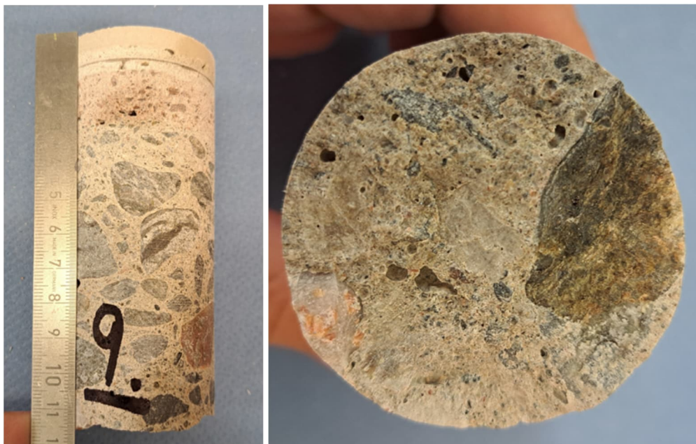
Kuvat 34 a ja b. Näyte N9 altaan pohjasta. Näytteen ulkopinnassa on pintamateriaalit sekä 20 mm korjauslaastikerros, jonka alla runkobetoni. Näytteen murtopinta leikkaa kiviainesten läpi.
