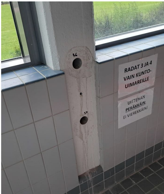
Kuva 62. Allashuoneen pilari, ulkoseinälinja. Pilarin alareuna on laatoitettu. Muilta osin pilarit on pinnoitettuja. Pilarin vierustoilla ovat ikkunapenkit, joiden kautta korvausilma tulee allashalliin.
