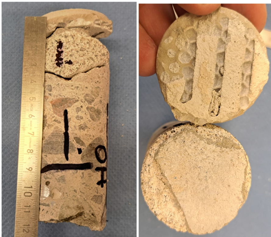
Kuvat 26 a ja b. Näyte N1 altaan seinästä. Näytteen ulkopinnassa on pintarakenteet, joiden alla on noin 25–30 mm:n tasoitekerros. Pintarakenteet ja tasoite irtosivat porauksen yhteydessä. Laatan kiinnitys alustaan on puutteellinen johtuen kiinnityslaastin peittoasteesta. Tasoitteen alla on runkobetoni, jossa raudoite noin 95 mm:n syvyydellä rakenteen ulkopinnasta. Raudoitteet ovat silmämääräisesti arvioituna hyväkuntoisia.
