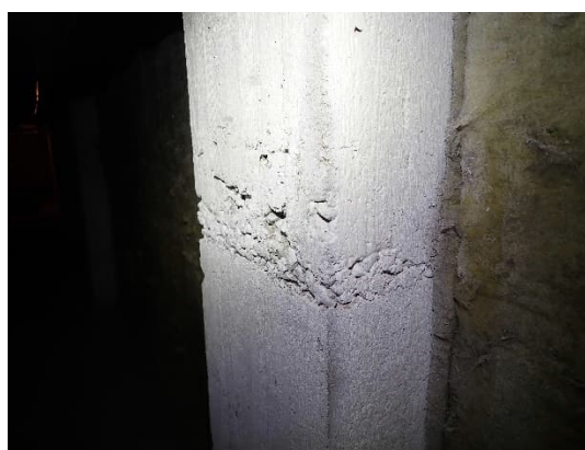
Kuva 68. Pilarit huoltokäytävällä ulkoseinällä. Pilareiden betoni on paikoin harvaa.
