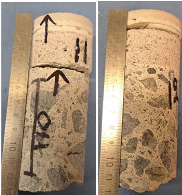
Kuvat 36 a ja b. Näytteet N11 ja N12 altaan pohjasta. Näytteessä on pintarakenteet, joiden alla noin 20 mm:n laastikerros. Näytteen N11 korjauslaastikerros irtosi poratessa runkobetonista. Näytteen N12 pintarakenteet irtosivat poratessa.
