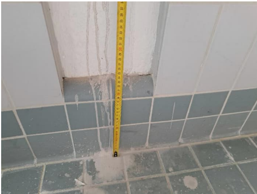
Kuva 63. Allashuoneen pilari, ulkoseinälinja. Pilarit ovat alaosastaan laatoitettu noin 230 mm:n korkeuteen. Pilarin alaosaan on tehty holkkaylösnosto, jota vasten laatoitus on nostettu. Silmämääräisesti arvioituna ulkoseinälinjan pilareissa ei havaittu pinta- tai betonirakenteiden vaurioitumista.
