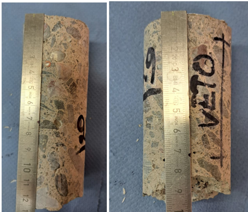
Kuvat 75 a ja b. Näytteet N28-N29 allashuoneen pilareista. Näytteessä N26 raudoite sijaitsee noin 15 mm:n syvyydellä rakenteen ulkopinnasta. Näytteiden betonissa tai betonin raudoitteessa ei havaittu silmämääräisesti viitteitä vaurioitumisesta.
