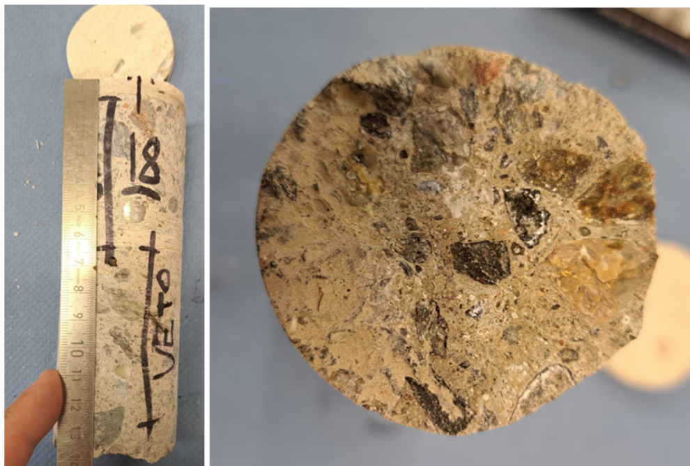
Kuvat 54 a ja b. Näyte N18 lastenaltaan seinästä. Näytteen ulkopinnassa on pintarakenteet, jonka alla tasoite. Pintarakenteet irtosivat poratessa. Näytteessä raudoite on noin 55 mm:n syvyydellä rakenteen ulkopinnasta. Raudoite on silmämääräisesti arvioituna hyväkuntoinen. Näytteen murtopinnan kiviaineksessa on härmettä.
