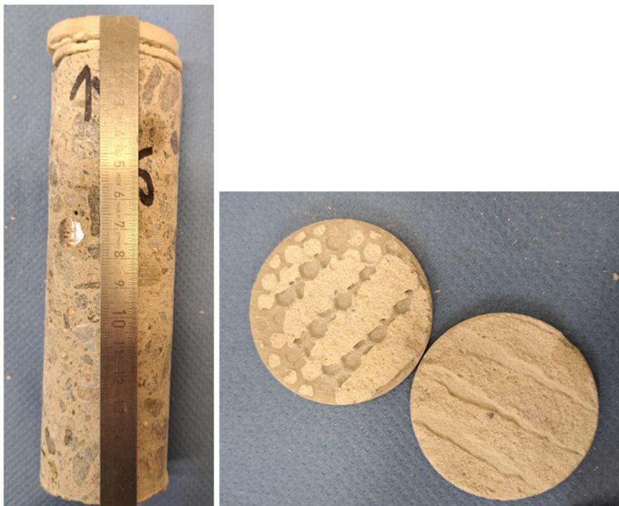
Kuvat 52 a ja b. Näyte N15 lastenaltaan seinästä. Näytteen ulkopinnassa on pintarakenteet, jotka irtosivat poratessa. Laatan kiinnityslaastin peittoaste on puutteellinen ja laatan tartunta alustaan on jäänyt puutteelliseksi. Betonin raudoite sijaitsee noin 70 mm syvyydellä rakenteen pinnasta. Raudoite on silmämääräisesti arvioituna hyväkuntoinen.
