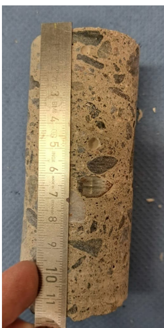
Kuva 90. Näyte N48, Näytteessä raudoite sijaitsee noin 60 mm:n syvyydellä rakenteen ulkopinnasta, murtopinnalla. Näytteiden betonissa tai betonin raudoitteessa ei havaittu silmämääräisesti viitteitä vaurioitumisesta.
