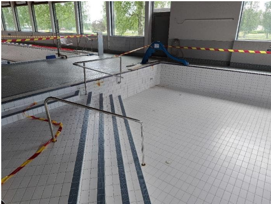
Kuva 39. Yleiskuva lastenaltaasta. Kulku lastenaltaaseen on järjestetty portailla, joiden vierustoilla on käsijohteet. Portaiden reunoilla on tehostelaatoitus.
