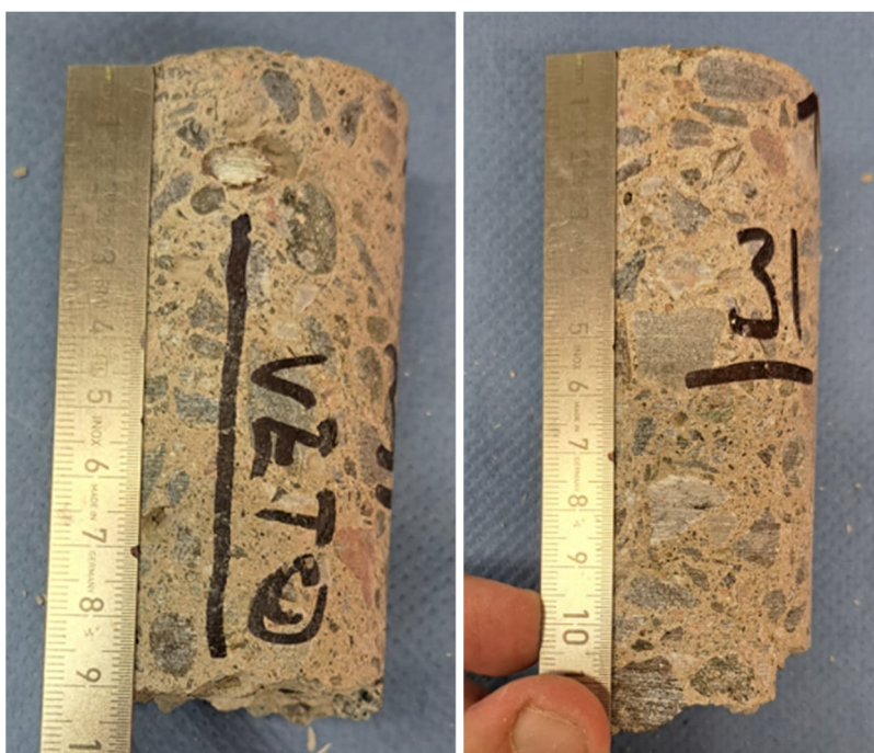
Kuvat 76 a ja b. Näytteet N30-N31 allashuoneen pilareista. Näytteessä N30 raudoite sijaitsee noin 10 mm:n syvyydellä rakenteen ulkopinnasta. Näytteiden betonissa tai betonin raudoitteessa ei havaittu silmämääräisesti viitteitä vaurioitumisesta.
