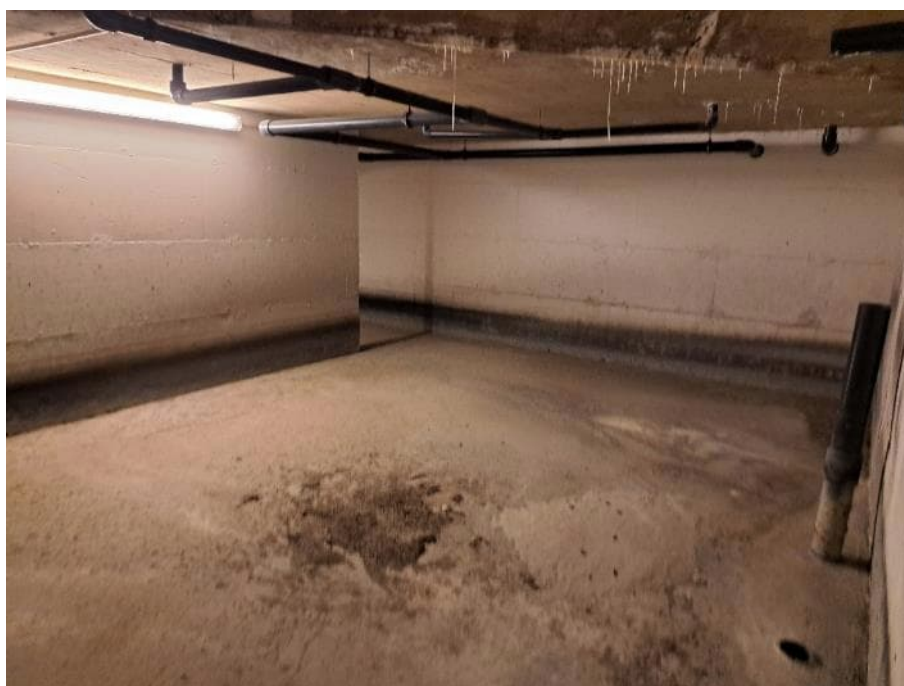
Kuva 86. Pieni taseusallas, lastenaltaan alapuoli. Lastenaltaan alapinnassa on kohtalaisen paljon kiteytymiä. Altaan pohjan pinnoite on kulunut.
