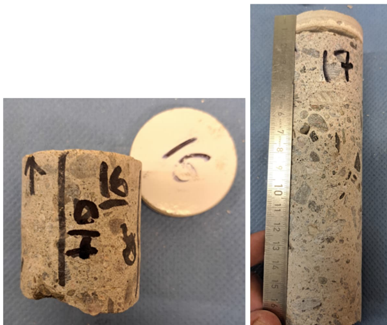
Kuva 53. Näytteet N16 ja N17 lastenaltaan seinästä. Näytteiden ulkopinnassa on pintarakenteet, jonka alla tasoite. Pintarakenteet irtosivat poratessa. Näytteessä N17 raudoite on noin 45 mm:n syvyydellä rakenteen ulkopinnasta. Raudoite on silmämääräisesti arvioituna hyväkuntoinen.
