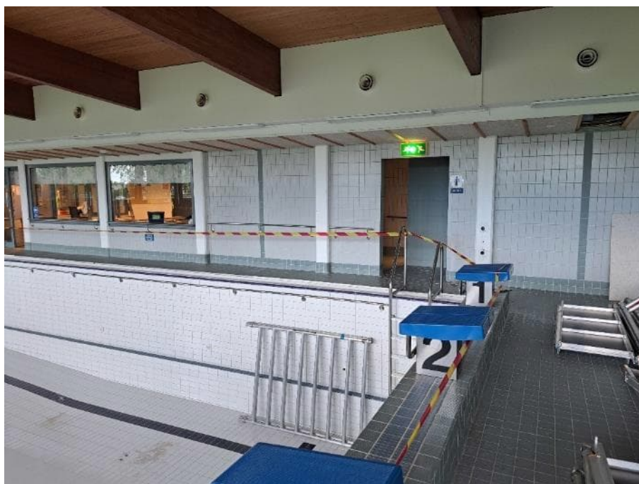
Kuva 6. 25 metrin altaan syvä pääty. Altaan päädyssä on koroke, jonka päällä on teräs-/muovirakenteiset lähtötelineet.
