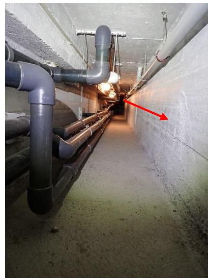
Kuva 12. Näyte ASB13 (Kellarin mv-seinän maali) ei sisällä asbestia.
