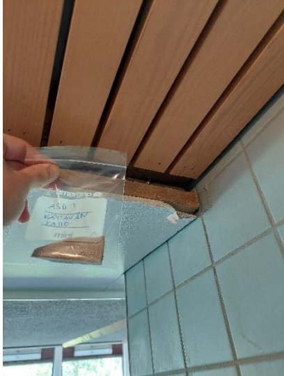
Kuva 1. Näyte ASB1 (Sisäverhouslevy, Käytävän katto, Kuitusementtilevy (8 mm, ruuvikiinnitys)) ei sisällä asbestia.
