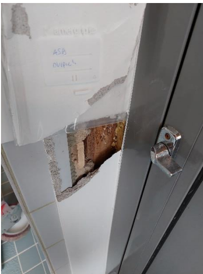
Kuva 11. Näyte ASB12 (Sisäverhouslevy, ovipieli, kuitusementtilevy) ei sisällä asbestia.
