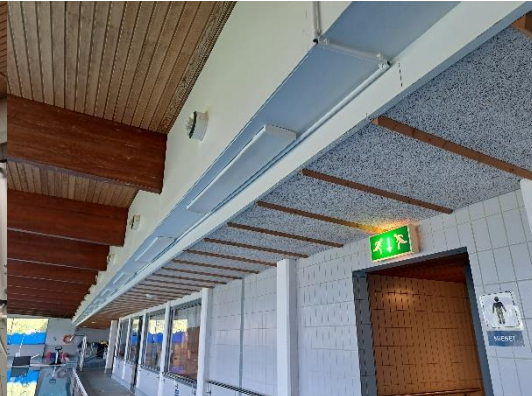
Kuva 19. Yleiskuva käytävältä. Pintamateriaalit ovat vuodelta 2005.
