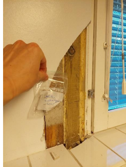
Kuva 2. Näyte ASB2 (Sisäverhouslevy ulkoseinä, Kuitusementtilevy (8 mm, ruuvikiinnitys)) ei sisällä asbestia.
