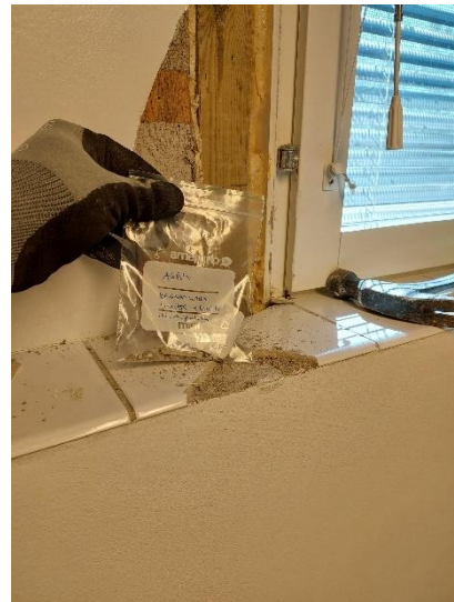
Kuva 4. Näyte ASB4 (Keraaminen laatta + sauma- ja kiinnityslaasti, ikkunapenkki) ei sisällä asbestia.
