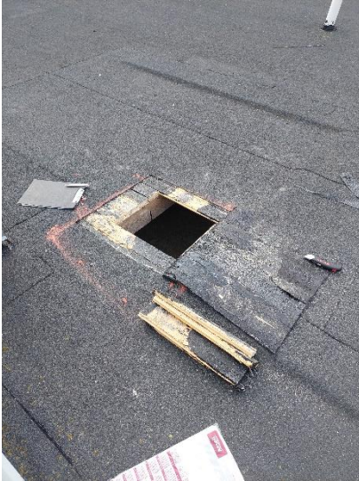
Kuva 9. Näyte ASB10 + PAH (vesikate) ei sisällä asbestia, eikä sen PAH-yhdistepitoisuudet ylitä vaarallisen jätteen raja-arvoja.
