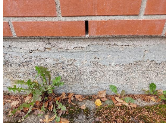
Kuva 6. Näyte ASB6 (sokkelimaali) ei sisällä asbestia.
