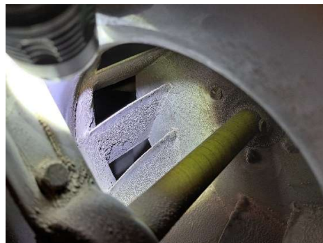
Kuva 10. Hihnavetoinen poistoilmapuhallin. Puhaltimen siivekkeissä on melko runsasta pölykertymää.
