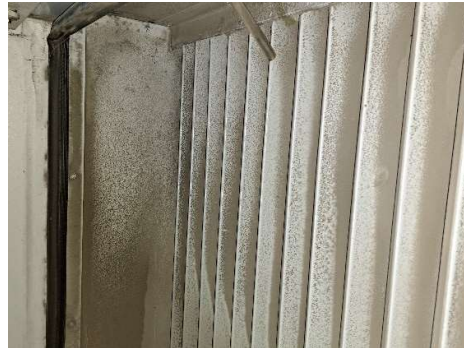
Kuva 9. Tuloilmasuodatin on puhdas. Suodatinkammiossa ja lämmityspatterin painepuolella on hienojakoista epäpuhtautta ja suodatinkehyksen tiiviste on rikkiäinen.
