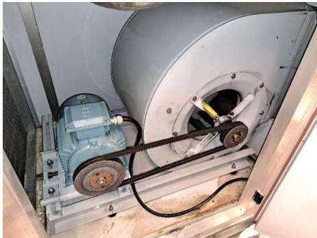
Kuva 5. Hihnavetoinen tuloilmapuhallin on puhdas ja käyntiäänensä on aistinvaraisesti arvioituna normaali.
