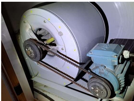
Kuva 10. Hihnavetoinen poistoilmapuhallin. Puhaltimen siivekkeissä on melko runsasta pölykertymää.
