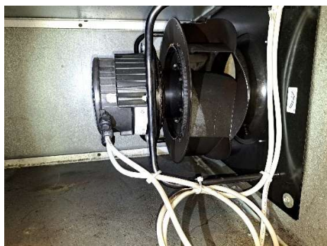
Kuva 16. Poistoilmapuhallin on uusittu suoravetopuhaltimeksi.
