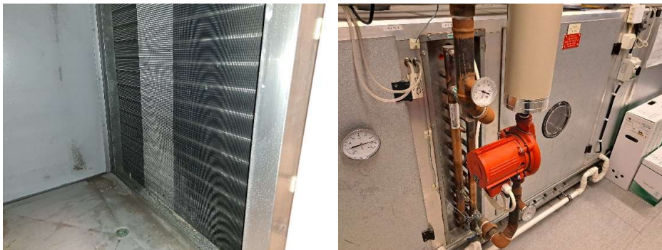
Kuva 3. Lämmityspatterissa on vähäistä epäpuhtauskertymää. Lämmitysputkistossa on pintapuolista korroosiota.
