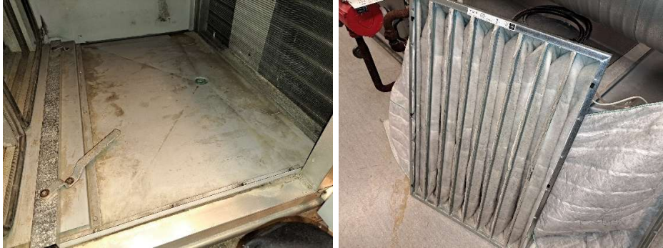
Kuva 2. Suodatinkammio on melko likainen ja suodatinkehyksen tiivisteet ovat osin kovettuneet / huonokuntoiset. Tuloilmasuodatin on puhdas.
