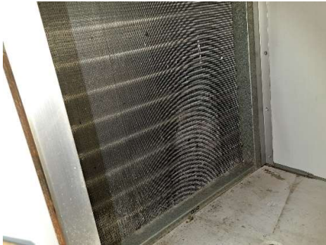
Kuva 9. Tuloilmasuodatin on puhdas. Suodatinkammiossa ja lämmityspatterin painepuolella on hienojakoista epäpuhtautta ja suodatinkehyksen tiiviste on rikkiäinen.
