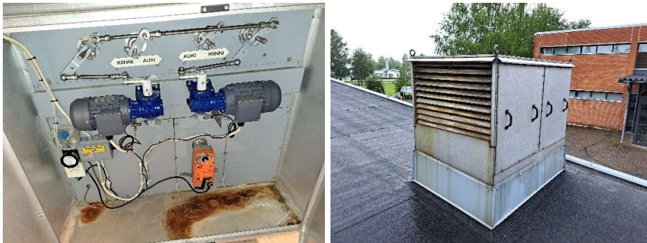
Kuva 3. Lämmityspatterissa on vähäistä epäpuhtauskertymää. Lämmitysputkistossa on pintapuolista korroosiota.
