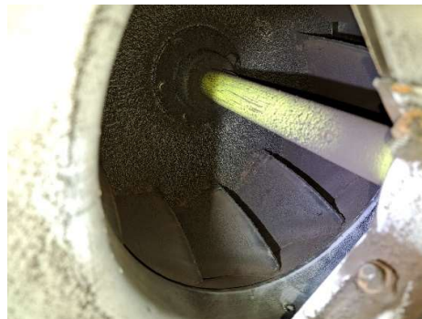
Kuva 5. Hihnavetoinen tuloilmapuhallin on puhdas ja käyntiäänensä on aistinvaraisesti arvioituna normaali.
