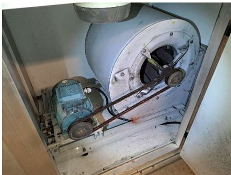
Kuva 5. Hihnavetoinen tuloilmapuhallin on puhdas ja käyntiäänensä on aistinvaraisesti arvioituna normaali.
