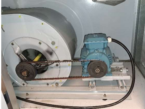
Kuva 8. Hihnavetoinen tuloilmapuhallin on puhdas ja käyntiäänä on aistinvaraisen arvion perusteella normaali.
