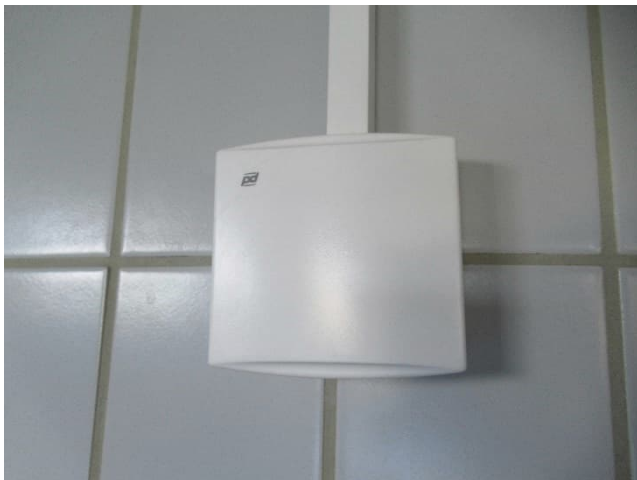
Huoneanturi allastilassa.
