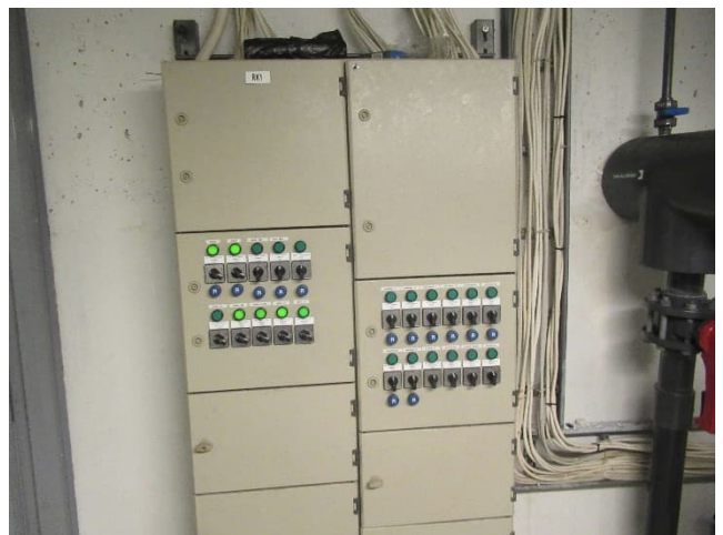
Vedenkäsittelyjärjestelmien keskus RK1.
