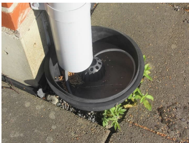
Sulanapitokaapeli syöksytorvessa.
