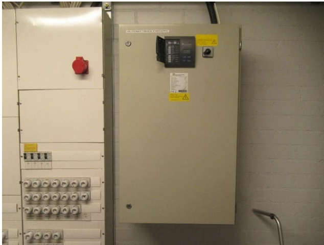
Kompensointilaitteisto 50 kVar.
