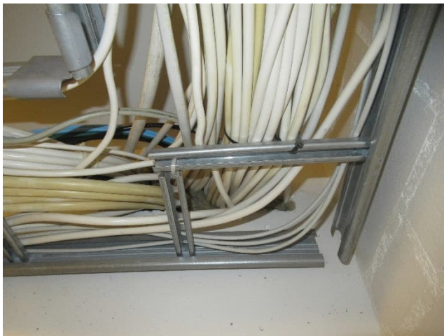
Tarkastettava läpivienti pääkeskustilassa.
