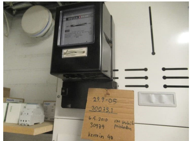
Sähköenergiankulutuksen takamittaus.
