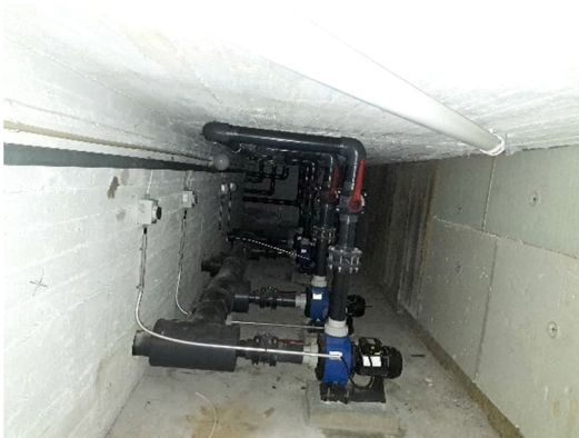
Kuva 30. Vanhojen kaivojen suuntaan ei lähde viemäreitä uima-altaan huoltotunnelista.
