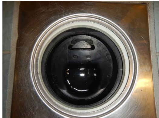
Kuva 32. Lattiakaivot ovat uusittuja hajulukollisia muovikaivoja.
