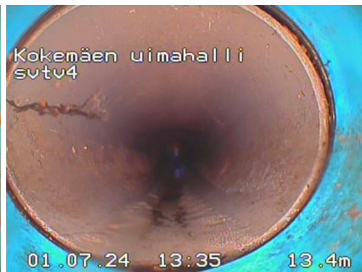
Kuva 16. Viemärimateriaali muuttuu.
