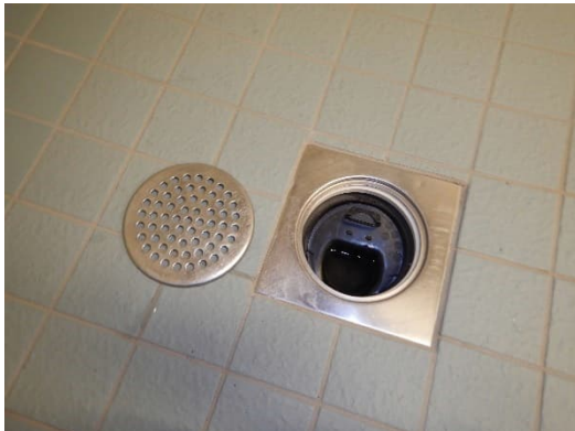
Kuva 31. Yleiskuva suihkutilan lattiakaivosta.
