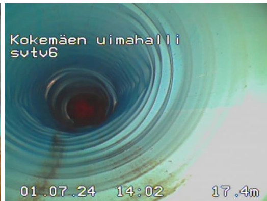
Kuva 20. Muodonmuutosta viemärissä.
