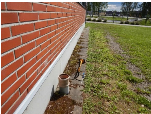
Kuva 43. Tarkastusputki, jonka käyttö-tarkoitus ei selvinnyt, ei kansistoa.
