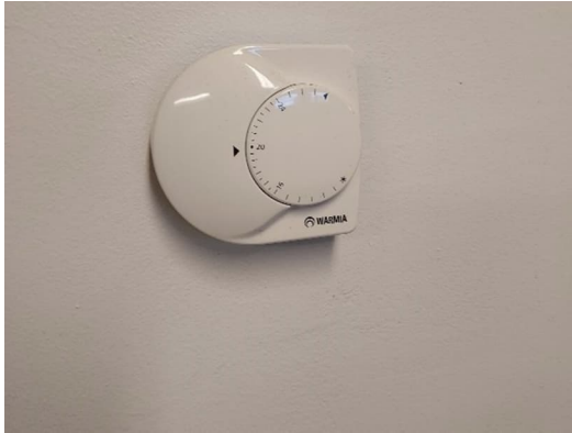
Kuva 9. Lattialämmityksen termostaatti.
