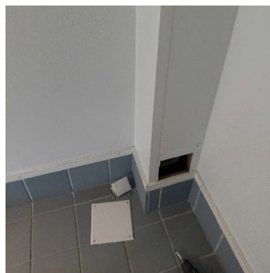
Kuva 25. Tuuletusviemäri nousee ylös kotelon sisällä.
