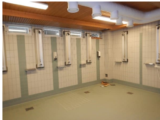
Kuva 18. Suihkutilojen vesijohtoasennuksia, putket koteloitu kattoon.
