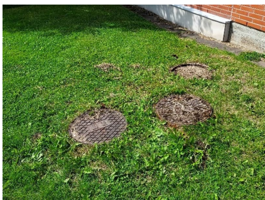
Kuva 28. Pysäköintialueen puolella päädyssä on 3 vanhaa kaivoa.
