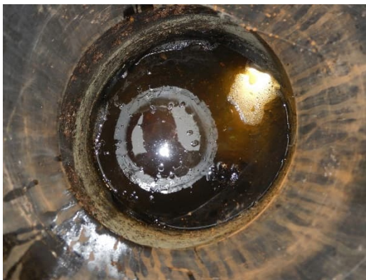
Kuva 37. Sadevesikaivot ovat uusittuja muovikaivoja, svtk1
