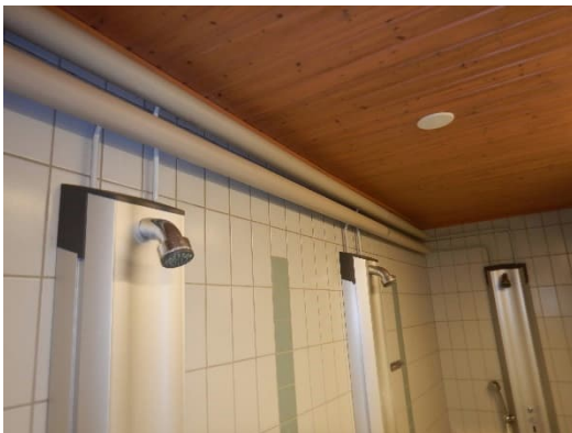
Kuva 17. Suihkutilojen vesijohtoasennuksia, putket näkyvillä.
