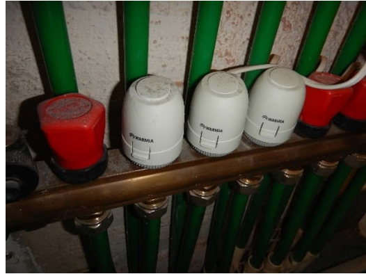
Kuva 10. Jakotukin toimilaitteita.
