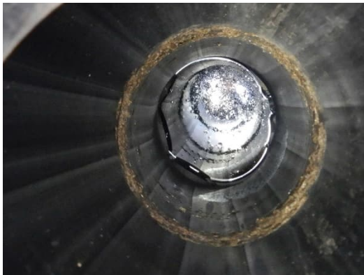
Kuva 39. Kaivo svtk4. Tähän on johdettu uima-altaiden tyhjennysvedet. Kaivon reunalla merkkejä veden nousemisesta.
