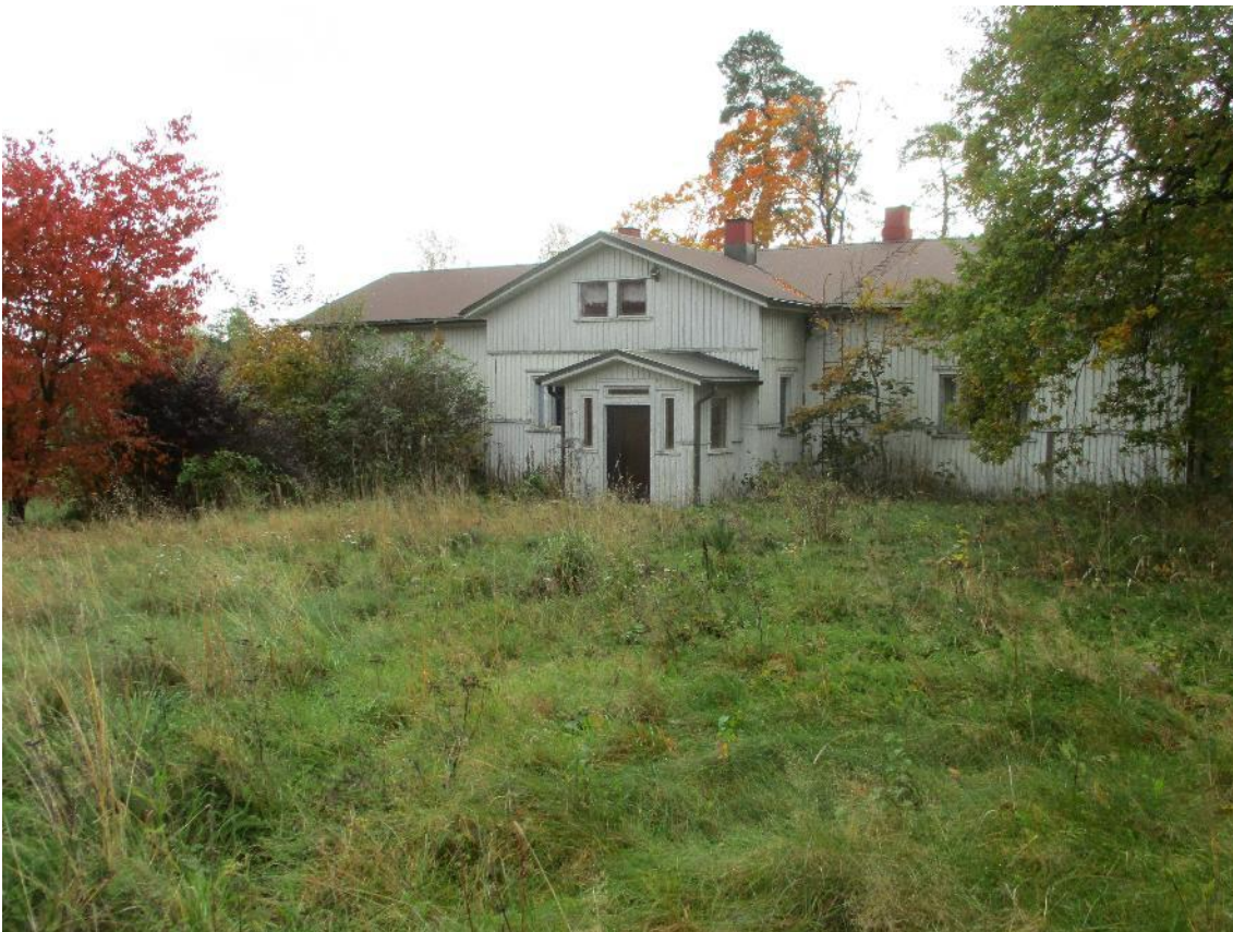
Kuva 5. Kotkan yksinäistalon päärakennus. Pohjoisesta.
