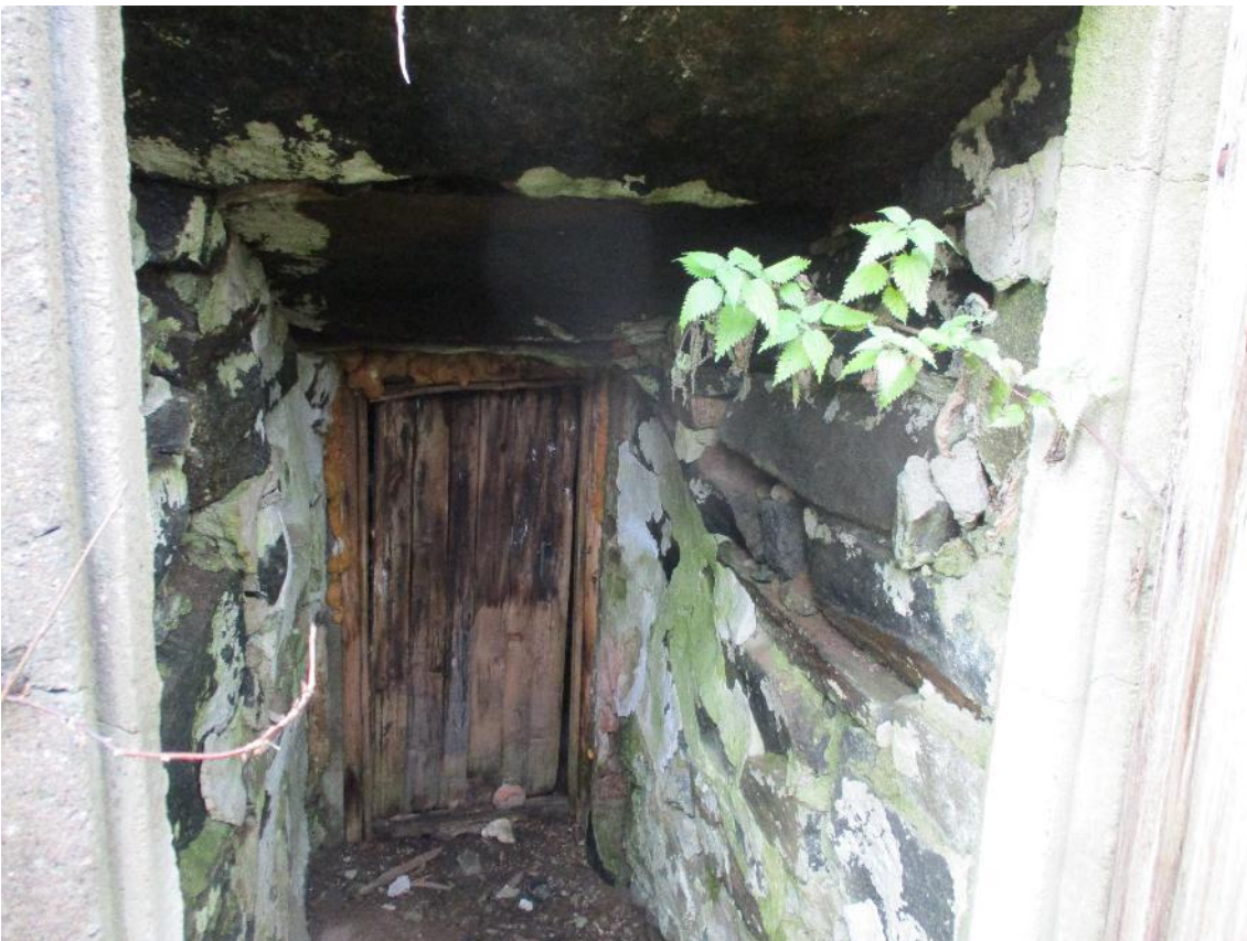
Kuva 7. Kotkan päärakennuksen itäpuolella olevan maakellarin eteistä. Idästä.
