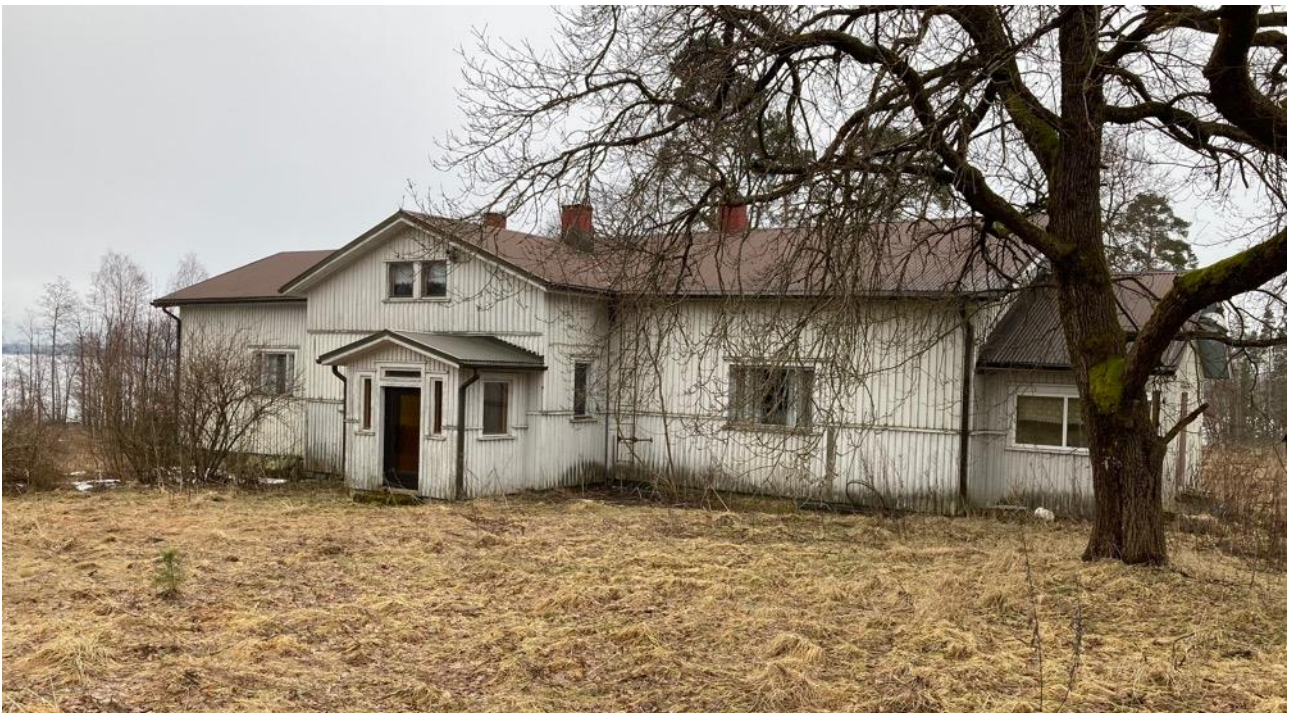
Kotkan tilan päärakennus
