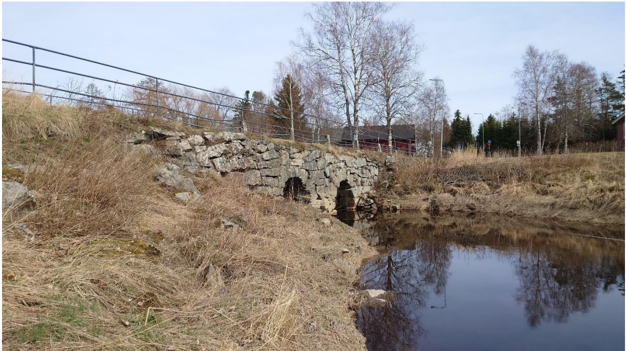
Kuva 55. Sillan eteläpuoli. Koilliseen. KL.
