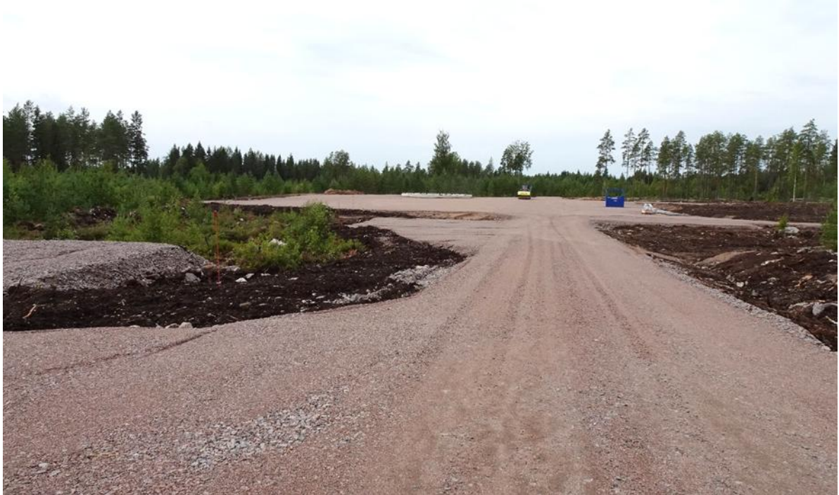
Kuva 9. Voimalan nostokentän rakennustyömaa. (Kuva J. Silvola, Ramboll).
