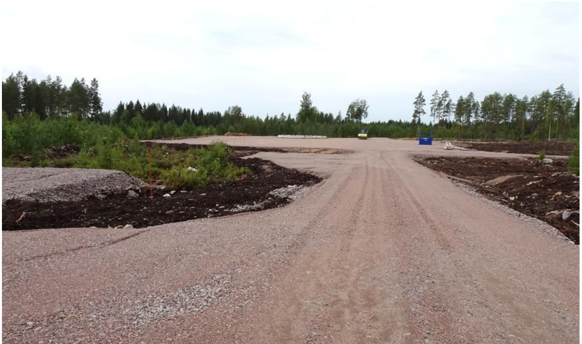
Kuva 9. Voimalan nostokentän rakennustyömaa. (Kuva J. Silvola, Ramboll).
